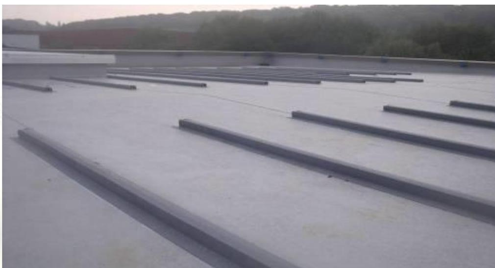
**Fig. 2 - Installation du profilé RENOLIT ALKORPLUS 81600 et son insert le long des joints longitudinaux**
